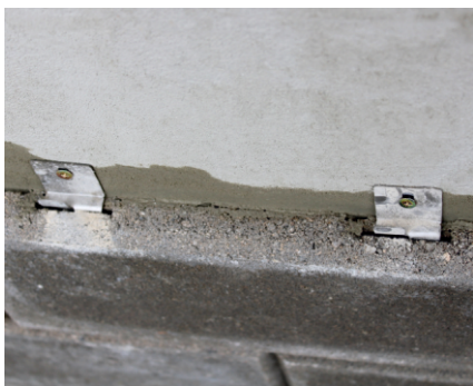
obr.7 - detail kotvení tvarovky k podkladu
