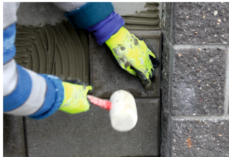
obr.2 - urovnání tvarovky do roviny
