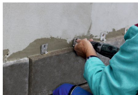
obr.6 - vložení hmoždinky a přivrtání vrtu k podkladu
