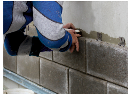
obr.3 - vyznačení otvoru pro kotvu
