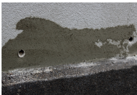
obr.5 - vyrtné a očištěné otvory pro kotvení
