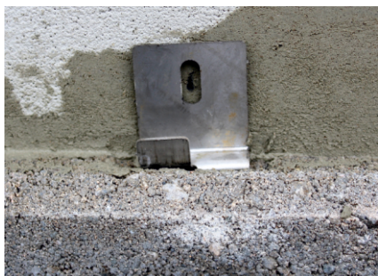
obr.4 - detail vyznačení otvoru pro kotvu
