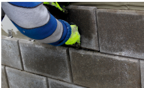
obr.8 - osazení tvarovky na kotvu
