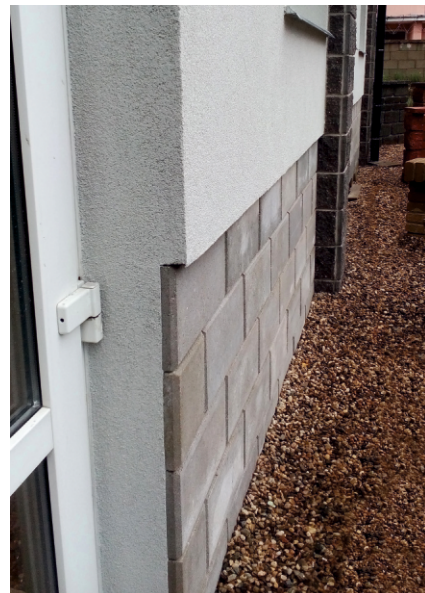
obr.9 - dokončená stěna z obkladových tvarovek PlayBlok
