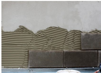
obr.1 - nanesení lepidla
